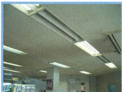
反射板取り付け(蛍光灯の間引き)
